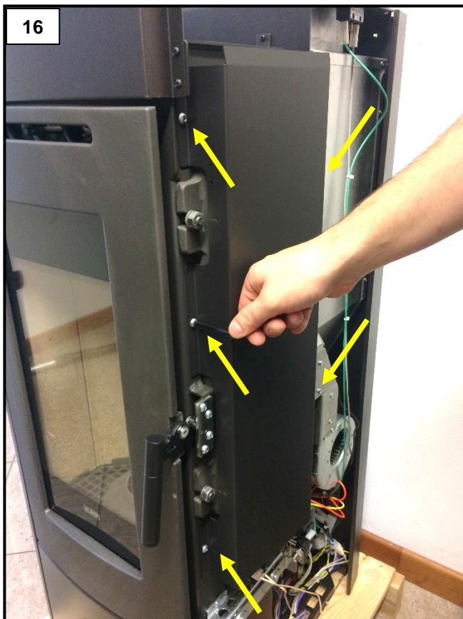
Abdeckung des Gusseisen-Wärmetauschers abnehmen (Abb. 17), dazu die fünf auf dem Foto gezeigten Schrauben herausdrehen (Abb. 16).
